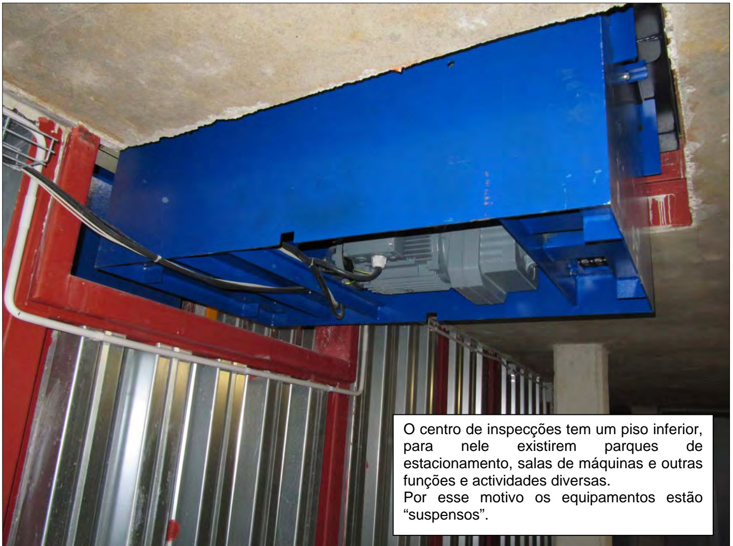
2 Linhas de inspecção para pesados. O fosso, pré construído, é uma unidade compacta com elevação. Permite a realização de vários tipos de simulação de carga.
